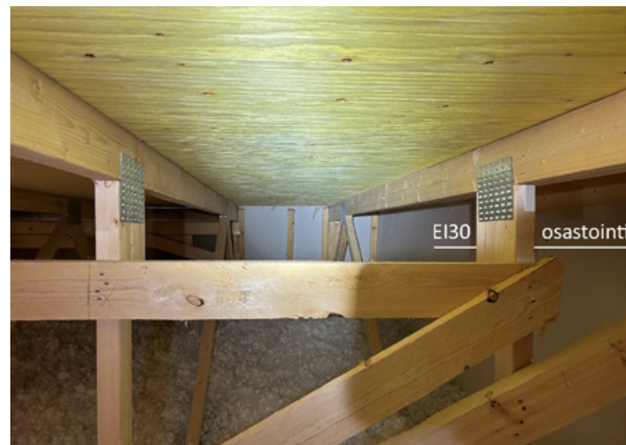
■ Kuva 5: Ullakon osastointi ja sen levitys ulkoseinällä (J-P Laakso / SPPL).
