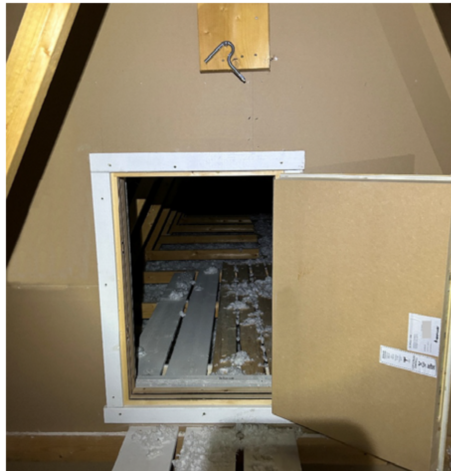
■ Kuva 17: Asianmukaisesti asennettu tehdasvalmisteinen luukku. (J-P Laakso / SPPL).
