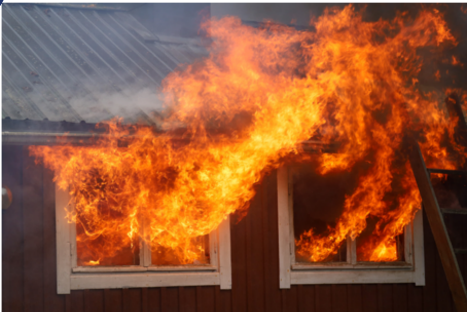
■ Kuva 2: Ikkunasta purkautuvat palokaasut leviävät ullakolle (Länsi-Uudenmaan pelastuslaitos).
