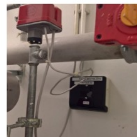
Hälytystieto paloilmittimelle (painekeytimeltä osoiteyksikölle)
