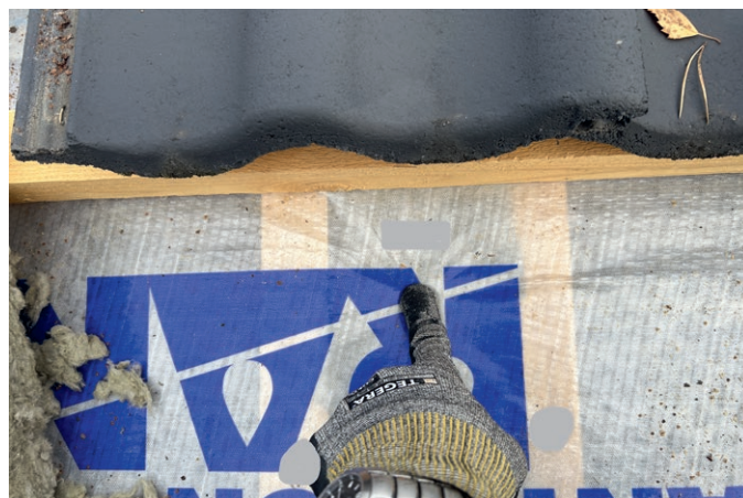
Kuva 6: Palo-osastoivan seinän ja vesikatton liitos katolta kuvattuna. Tukisoirojen välissä aluskatteen alla havaitaan tiivistysvilla (J-P Laakso/SPPL).
