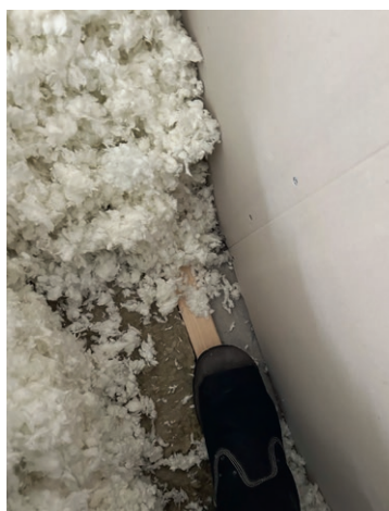
Kuva 14: Huoneistojen välissä sisäseinä kivirakenteinen ja ullakolla levyrakenteinen. Kivirakenteisia seiniä havaittiin noin 32 prosentissa aineiston kohteissa. Puhallusvillan pohjalla havaitaan levyvilla kerros (J-P Laakso/SPPL).
