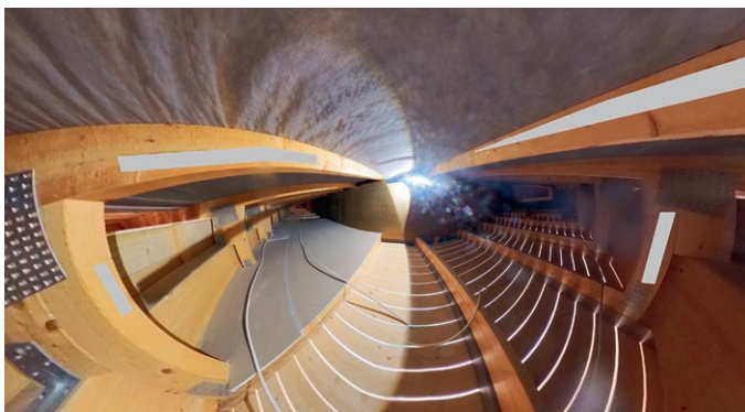
Kuva 16: Sisäänkäyntikatokas, joka avoin koko rakennuksen matkalla. Katoksen alapinta harvalaudoitettu. Levytyksen kohdalla asuntokohtaiset varastot (J-P Laakso/SPPL).
