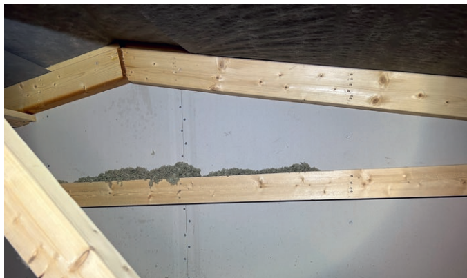
Kuva 5: Palo-osastoivan seinän ja vesikatton liitos, jossa tukisoiro kiinnitetty seinään (J-P Laakso/SPPL).
