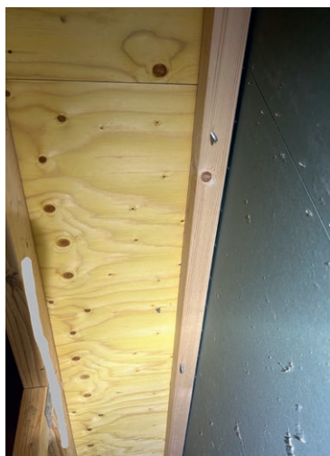
Kuva 12: Huopakatteellinen vesikatto kattovaneerilla. Toteutus vastaa rakennesuunnitelmaa (J-P Laakso/SPPL).
