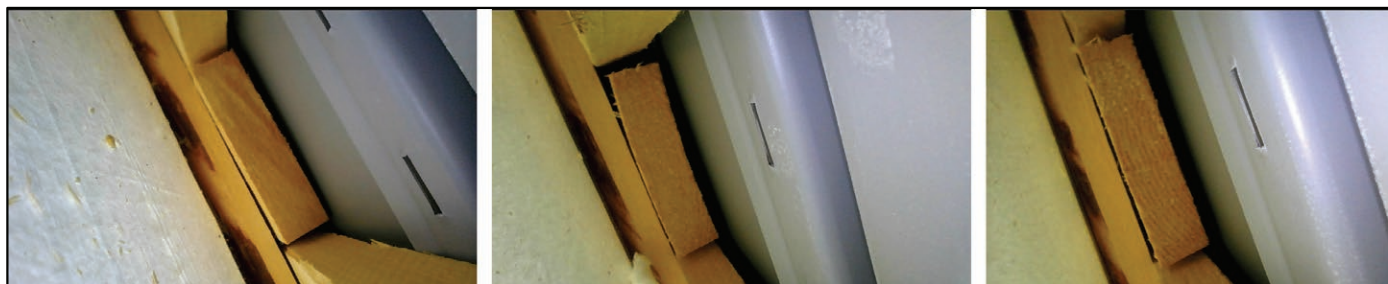
Kuva 9: Ruoteiden välin kapulointi kolmesta eri kohtaa (J-P Laakso/SPPL).
