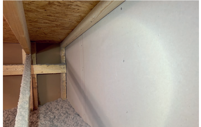
Kuva 1: Palo-osastoivan seinän ja vesikaton liitos, joka vastaa rakennesuunnitelmaa (J-P Laakso / SPPL).
