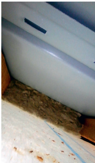
Kuva 7: Tiivistysvilla peltikatteen, ruoteiden ja seinän välissä (J-P Laakso/SPPL).
