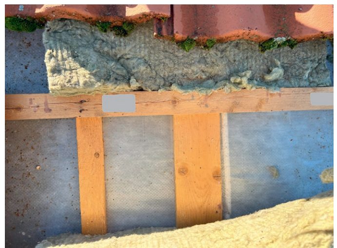
Kuva 3: Palo-osastoivan seinän ja vesikaton liitos katolta kuvattuna. Liitos vastaa osittain rakennesuunnitelmaa (J-P Laakso / SPPL).
