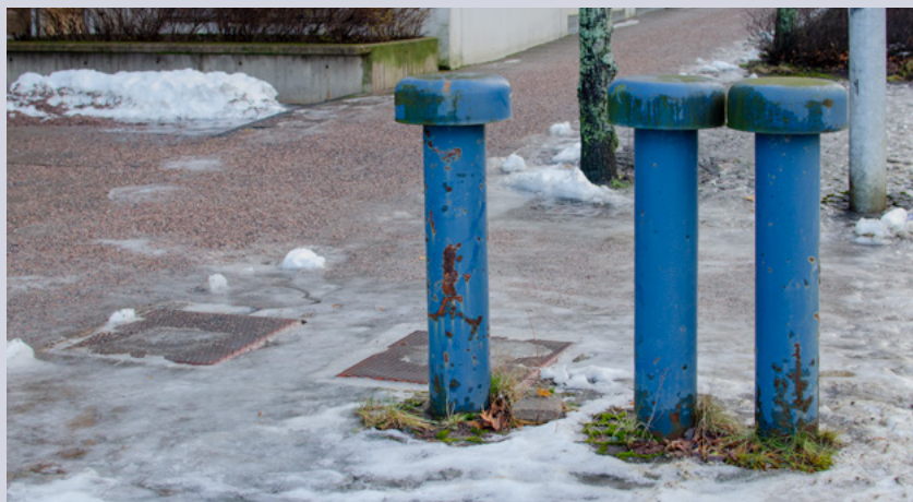
■ Poistumistien kansia ja ilmanottoputkia kadulla väestönsuojan ulkopuolella.
