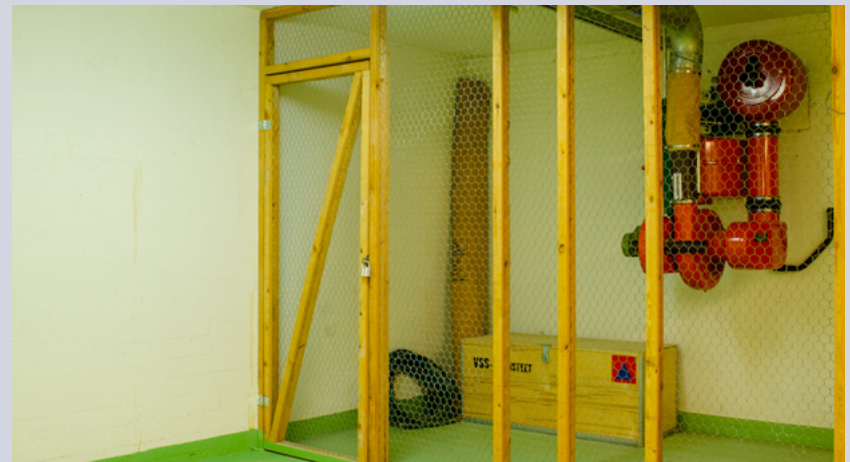
■ Väestönsuojan nurkassa varustelaatikko sekä sulkutelta pussiin pakattuna nojallaan.
