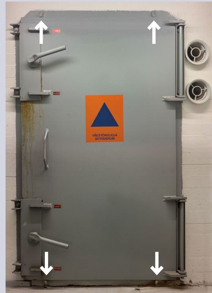
■ Väestönsuojan ovi. Tärähdyskiilat on merkitty kuvaan nuolilla.
