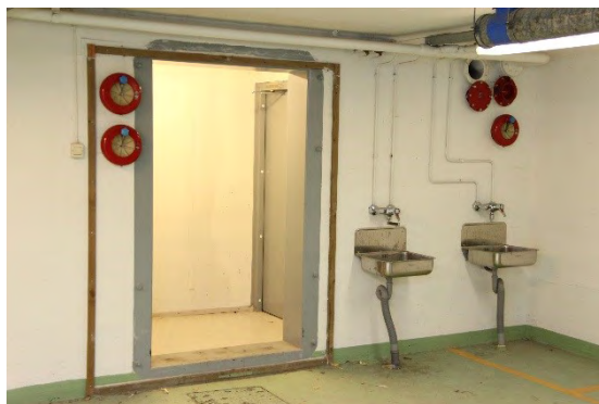
Kuva 17. Väestönsuojan sisäänkäynnin vieressä näkyvät vesipisteet sekä sen ympärillä rimoitukset sulkuteltan eli suojan eteisen rakentamista varten.
