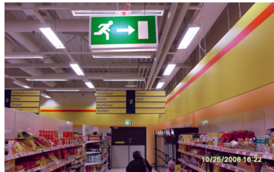
■ Kuva 14. Myymälän käytävälle sijoitettu jatkuvasti valaiseva opaste.
