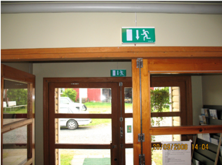
■ Kuva 26. Tuulikaapin sisällä ei tarvita poistumisopastetta silloin, kun sinne tullaan vain yhdestä suunnasta. Sisemmän oven yläpuolinen opaste on välttämätön ja riittävä. Kuvassa esiintyvä ulko-oven yläpuolinen opaste on tarpeeton.
