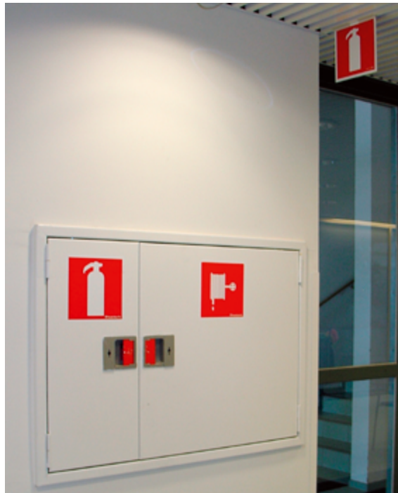
■ Kuva 16. Alkusammutuskalustokaappiin kiinnitetyt kilvet voivat olla pienikokoisia. Kaapille osoittava kilpi asennetaan helposti näkyvään paikkaan, yleensä huonetilan yläosaan.
