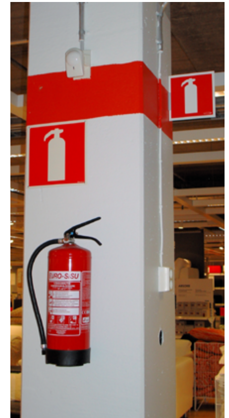
■ Kuva 29. Pilarissa olevana alkusammutuskaluston yleismerkkinä voidaan käyttää 200 mm:n levyistä punaista raitaa. Lisäksi kiinnitetään alkusammutuskaluston kohdalle alkusammutinta vastaava kilpi.
