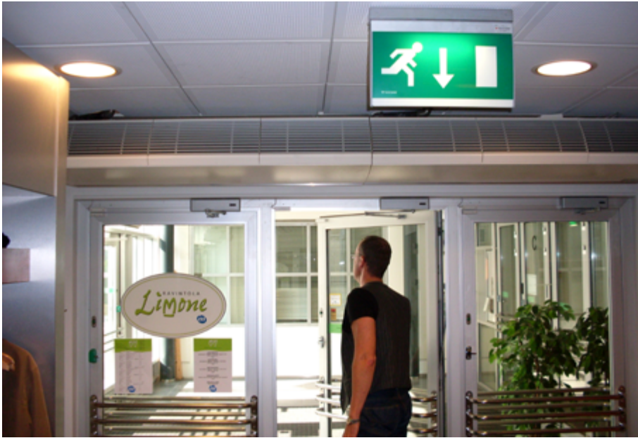
■ Kuva 18. Poistumisreitit varrella olevat ulos johtavat ovet merkitään oven yläpuolelle sijoitetulla kilvellä. Kuvassa jatkuvasti valaiseva opaste.
