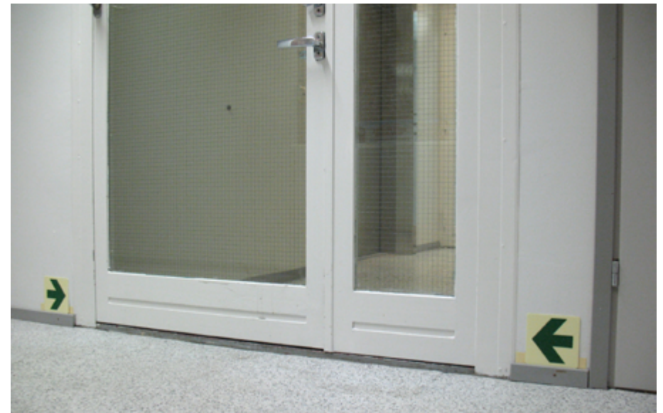
■ Kuva 21. Uloskäytävään johtavan kulkureitin tehostettu merkintä lattian rajaon sijoitetuilla jälkivalaisevilla nuolilla.
