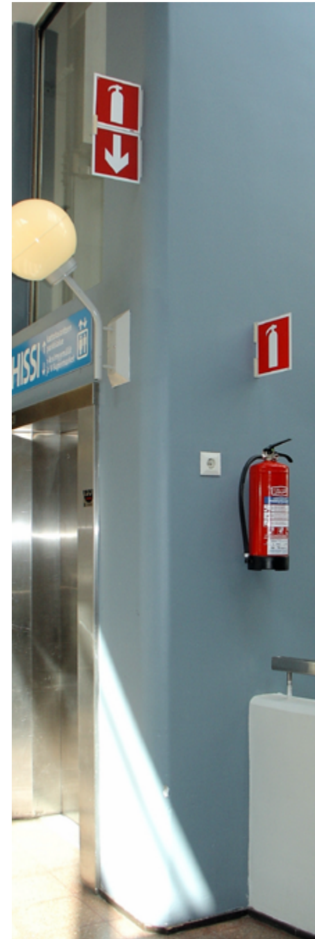
■ Kuva 28. Opastus alkusammuttimelle. Huom! Kuvan sammutin on sijoitettu hieman hankalaan paikkaan nurkan taakse, se on melko korkealla lattiatasosta ja kaiteen yläpuolella (putoamisvaara).
