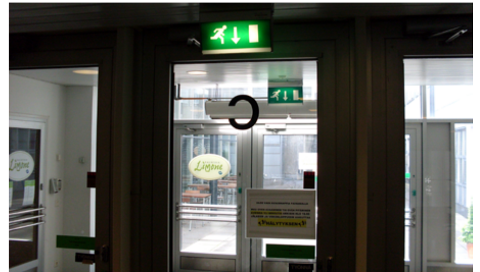
■ Kuva 25. Tuulikaapin sisällä tarvitaan poistumisopaste vain silloin, kun sinne tullaan eri suunnista ja jos ovissa on erehtymisen mahdollisuus.
