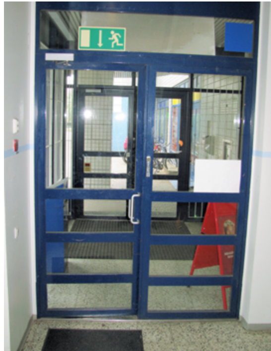
■ Kuva 18. Poistumisreitit varrella olevat ulos johtavat ovet merkitään oven yläpuolelle sijoitetulla kilvellä. Kuvassa jatkuvasti valaiseva opaste.
